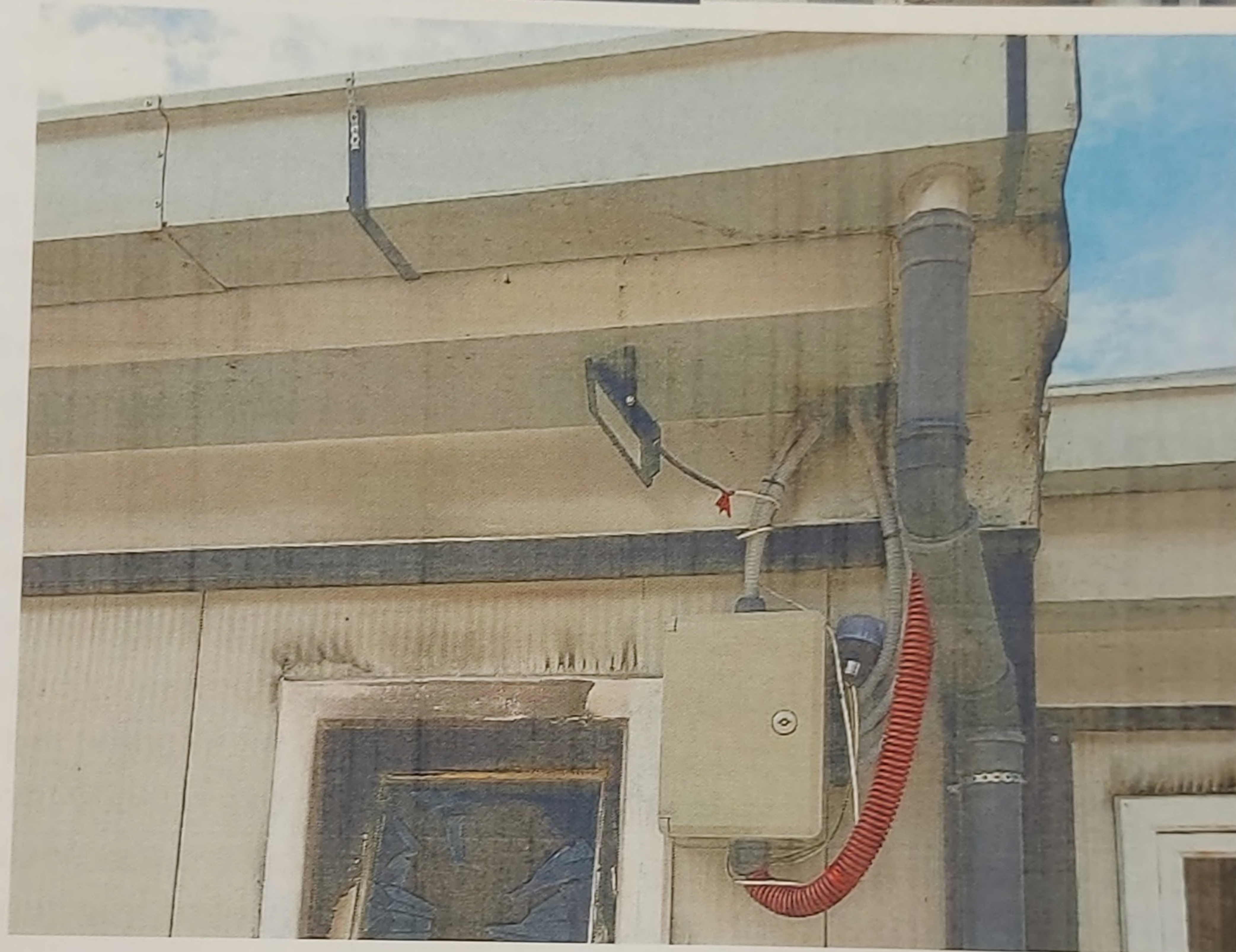
Слика 3. Доводни табли за внатрешната инсталација во објектот
